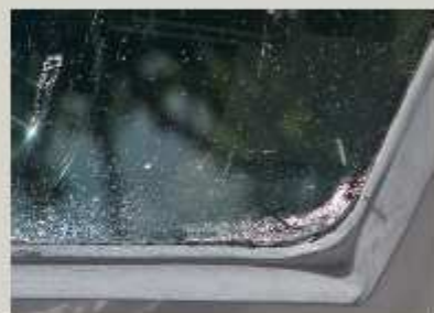
Ungeeignete Dichtmasse und alkoholhaltiger Fensterreiniger führen bei Acrylglas zu Spannungsrisskorrosion
